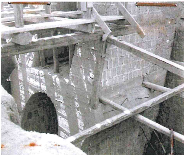
Figure 5 e 6 - realizzazione dei primi due ordini dei piloni in tufo con archi di collegamento in c.a.
