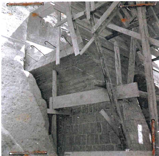
Figure 5 e 6 - realizzazione dei primi due ordini dei piloni in tufo con archi di collegamento in c.a.
